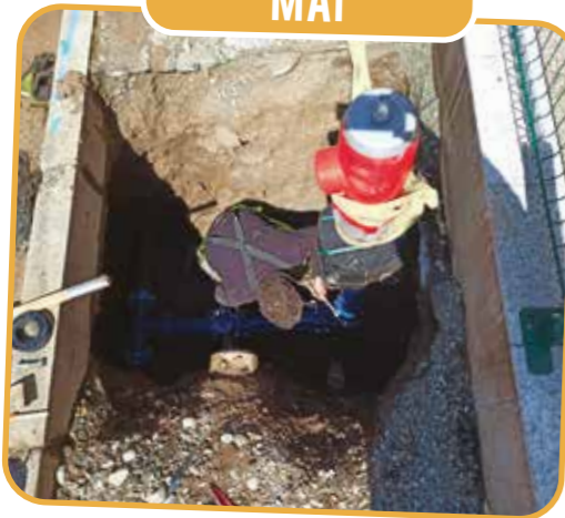
Remplacement de poteaux d'incendie, rue Georges Pompidou.
