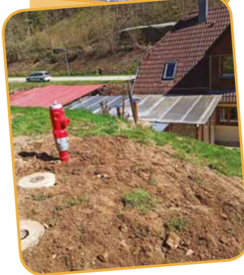
Remplacement de poteaux d'incendie, rue du Soultzbach.
