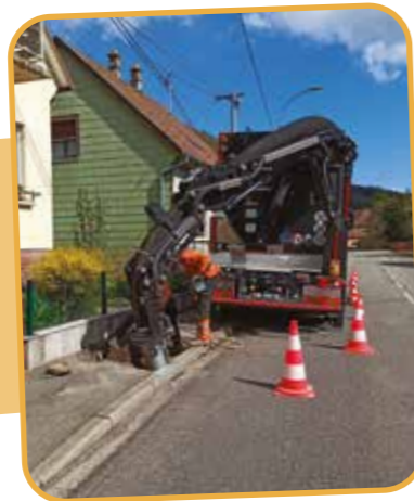
Terrassement par aspiration.
