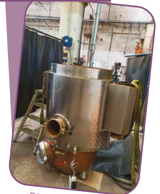
Réparation de l'alambic.
